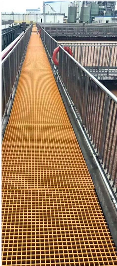
Конструкции из пултрузионных профилей обладают высокой стойкостью к воздействию технических и других агрессивных сред, не требуют дополнительной защиты и регулярного окрашивания, могут применяться на объектах химической и топливно-энергетической промышленности
