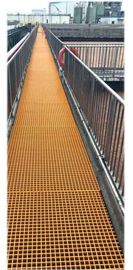
Конструкции из пултрузионных профилей обладают высокой стойкостью к воздействию технических и других агрессивных сред, не требуют дополнительной защиты и регулярного окрашивания, могут применяться на объектах химической и топливно-энергетической промышленности
