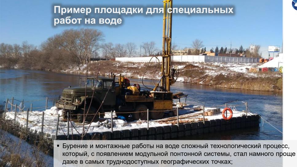
Благодаря надежной системе якорения, площадка остается неподвижной даже при сильном течении
