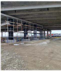
Усиление опор путепровода через ж/д пути автомобильной дороги А-160
