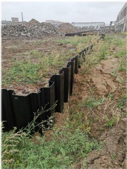
Стена в грунте при ликвидации выведенного из эксплуатации цеха ртутного электролиза, Иркутская область
