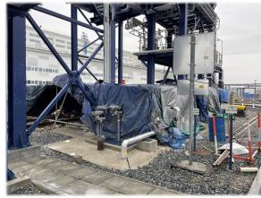
Омский НПЗ. Защитные покрытия бетонных конструкций переливной эстакады.
